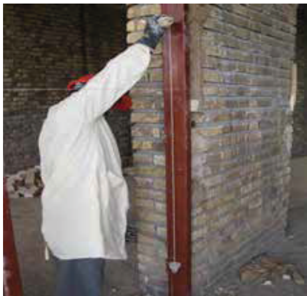
شکل ۳-۲۳: شاقول کردن وادار
