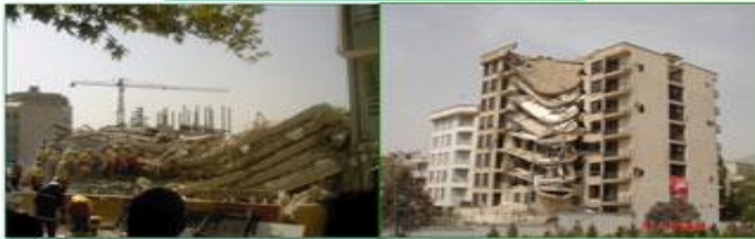
ساختمان سعادت آباد قبل و بعد از ریزش
