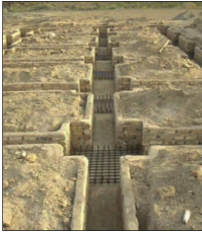
شکل ۳-۵۴ آرماتورگذاری پی تکی کلاف بندی شده
