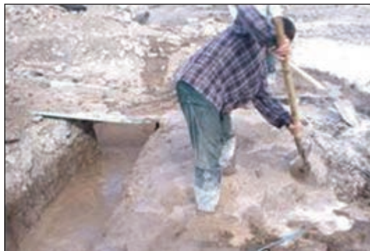
شکل ۳-۳۷ اجرای شفته آهک در فونداسیون
