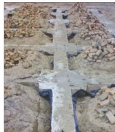
شکل ۳-۱۳۷ پی و شناژ بعد از بتن‌ریزی
