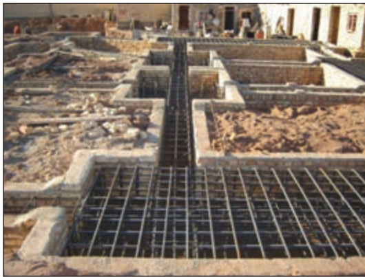
شکل ۳-۱۳۴ میلگردگذاری در پی کلاف بندی
