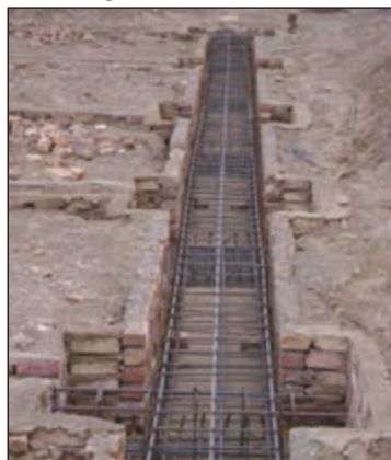
شکل ۳-۱۳۶ پی و شناژ قبل از بتن‌ریزی
