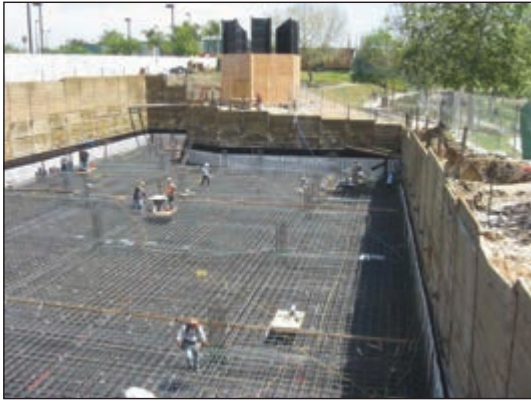
شکل ۳-۶۸ پی بتن مسلح یکپارچه (رادیه ژنرال)
