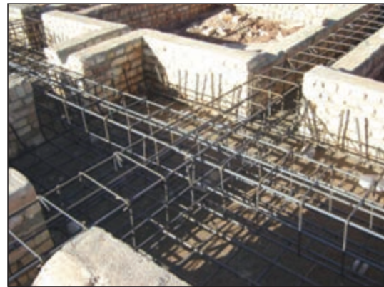
شکل ۳-۱۳۵ عبور میلگردهای شناژ در پی
