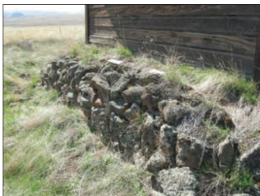
شکل ۳-۴۰ پی سنگی با سنگ لاشه
