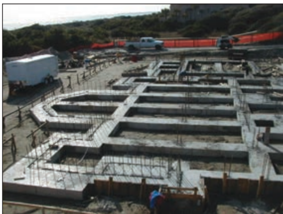
شکل ۳-۶۲ پی بتن مسلح نواری شبکه ای زیرستون
